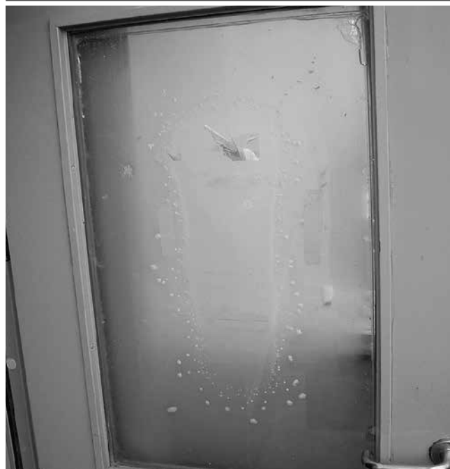
Рис. 4 Помутнение многослойного стекла с силикатным гелем
