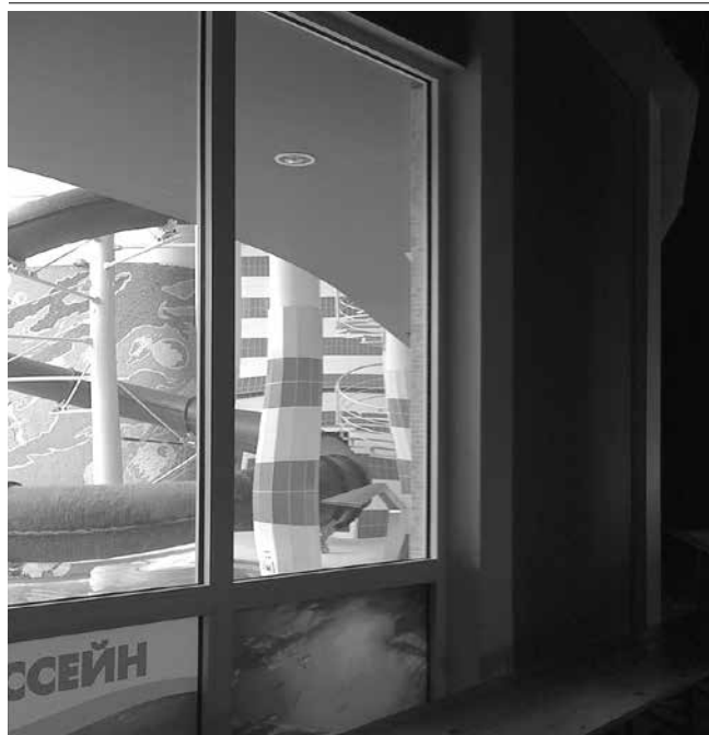
Рис. 5 Оптические искажения, вызванные изменением формы стекла
